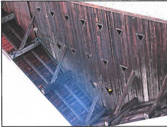
Photo 83 : Ouvertures géométriques dans le bardage
