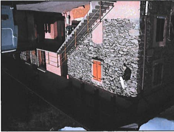
Photo 85 : Façade en pierres, large débord de toit
