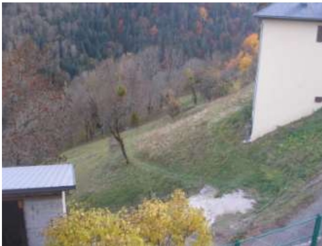
Coulée en zone rouge entre chapelle (perceptible à gauche sur le cliché) et ancienne école qui sert actuellement de logement, bâtiment à droite sur le cliché)
