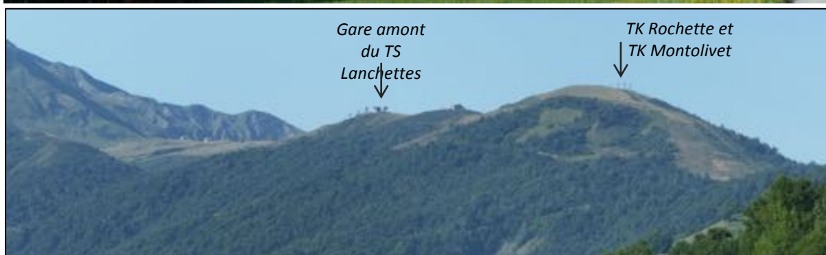
Vue sur une partie du site d'étude depuis la D94, au niveau de Combelouvière Epode – août 2019
