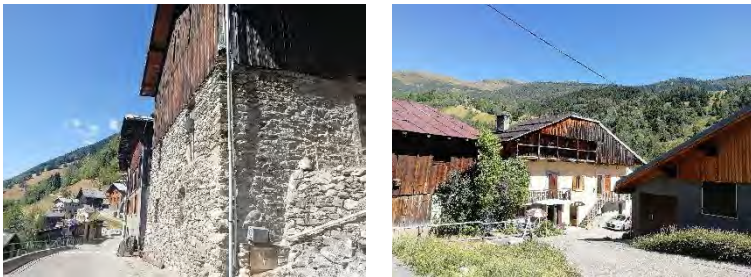
Des toitures à deux pans le plus souvent en tôles, bac acier, ou lauze Des greniers aux étages supérieurs du bâti en bois // Des bardages verticaux pour les murs en pignon Des façades en pierre ou crépis
