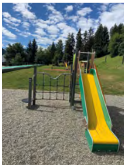
Installation d'un nouveau jeu à la station de Doucy
