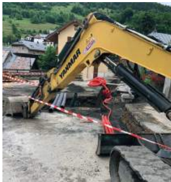
Travaux Route Saint André
