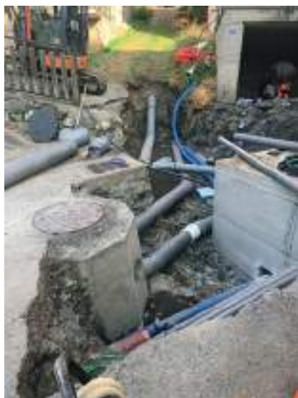
Travaux Route du Patrimoine
